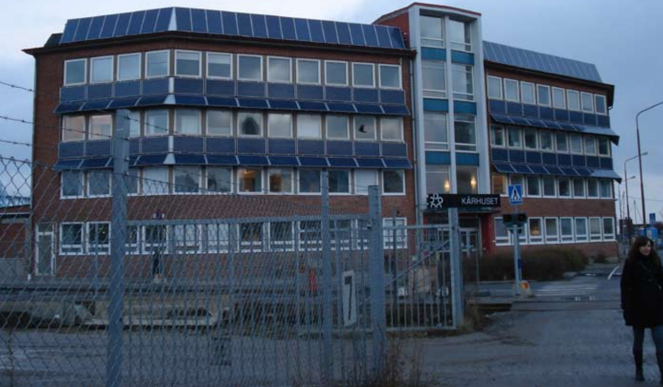
Aurinkopaneleilla vuorattu Malmön ammattikorkeakoulun rakennus.
