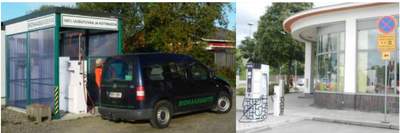
Kuva 8. Suomen ensimmäinen julkinen UE-metaaniasema (a) avattiin Laukaassa vuonna 2004 ja Suomen ensimmäinen julkinen UE-sähköasema (b) avattiin Turussa vuonna 2014.
